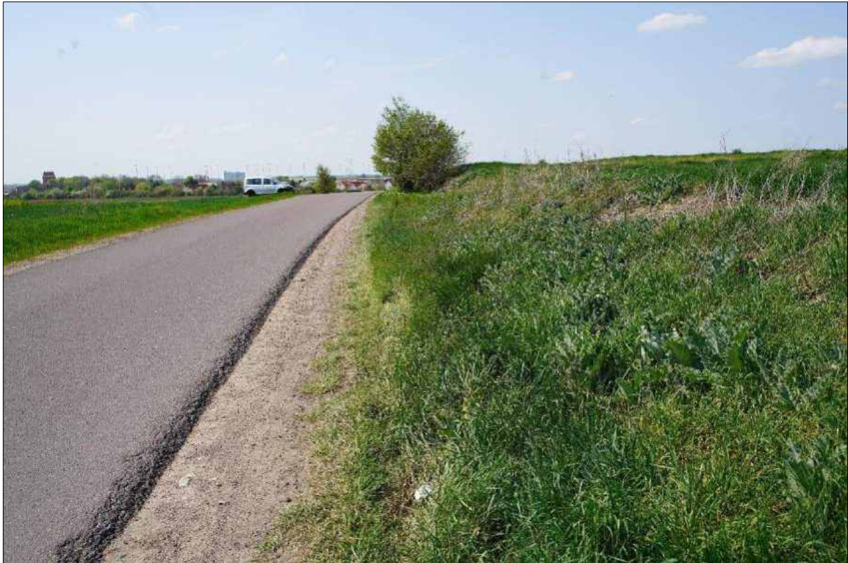
Südgrenze (Böschung) mit Fahrbahn des Ixelweges, Blick nach Westen.
