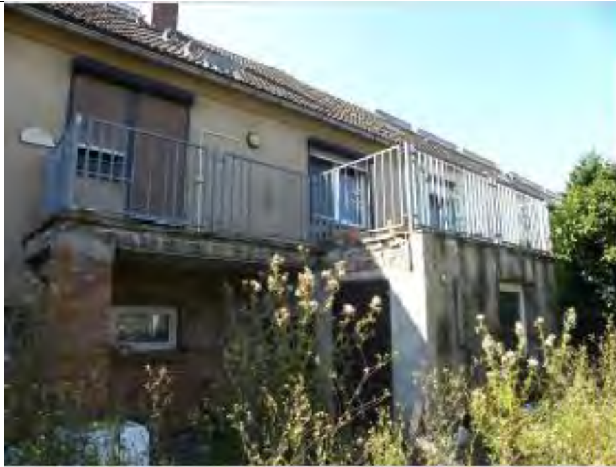
Bauzustand der Terrasse
