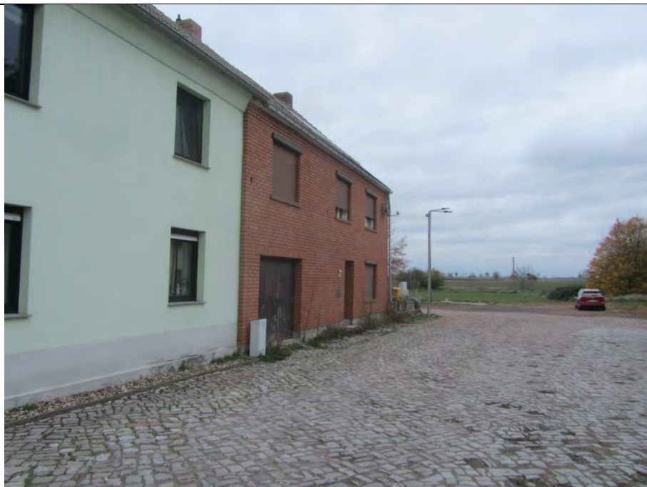
Blick aus Südwest
