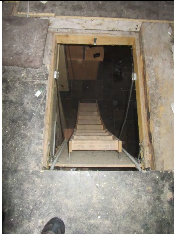
Blick vom Dachboden zum Flur/Arbeitsbereich
