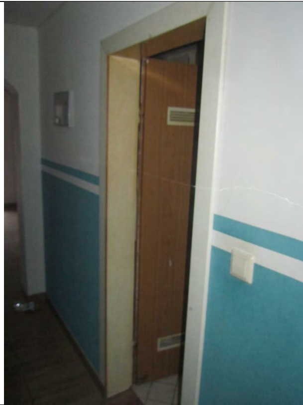
Weg zurück im Flur Richtung Eingang auf der rechten Seite. bzw. vom Eingang betrachtet im Flur die erste Tür auf der linken Seite, Richtung Südwest befindet sich ein Badezimmer.
