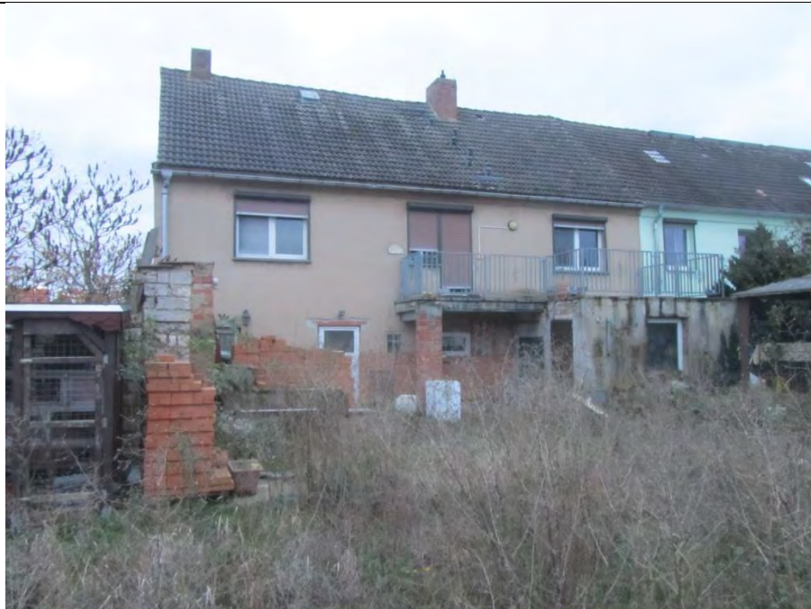
Blick aus dem Garten auf die Rückseite des Hauses (Nordseite).
