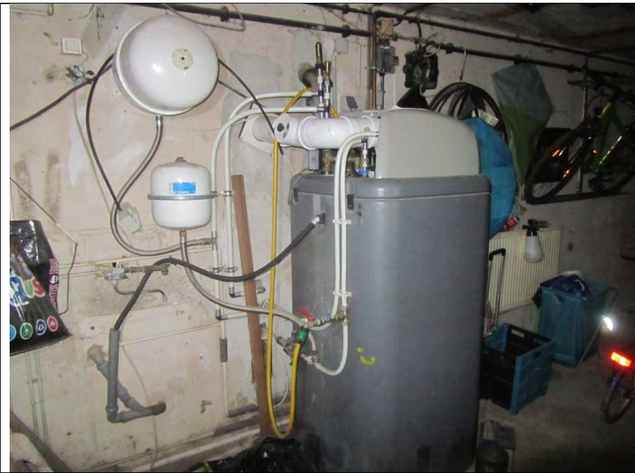
Heizungsanlage mit Warmwasserspeicher.
