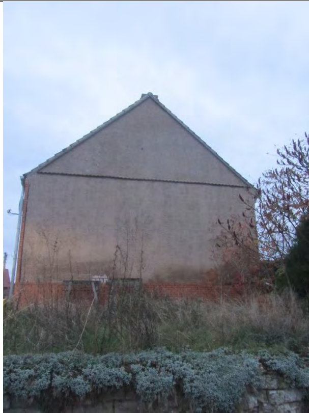
Giebelseite befindet sich im Osten.
