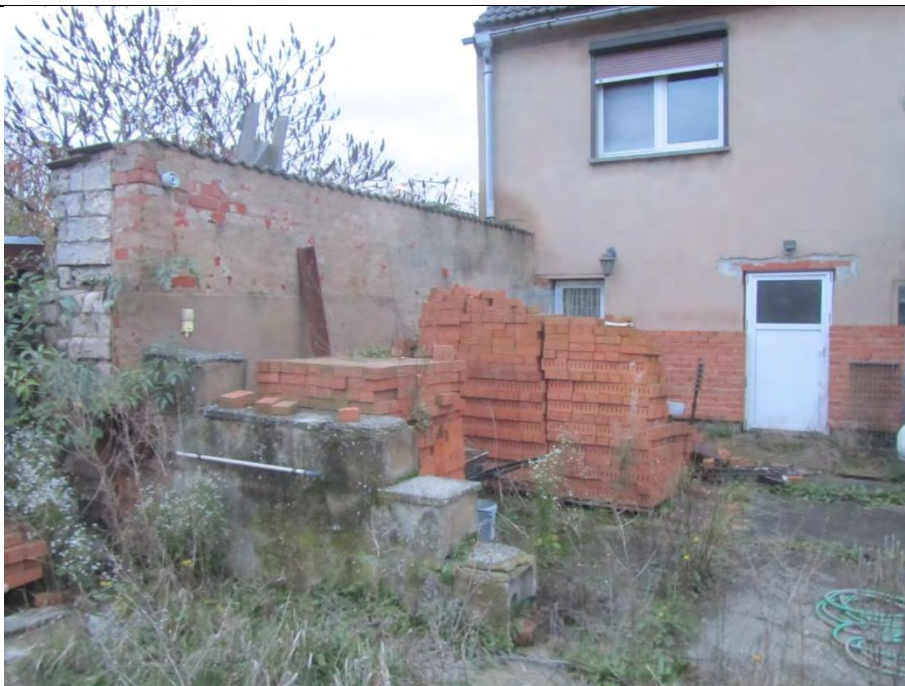
Verklinkerung der Fassade wurde begonnen. Klinkersteine am Hintereingang vorhanden.
