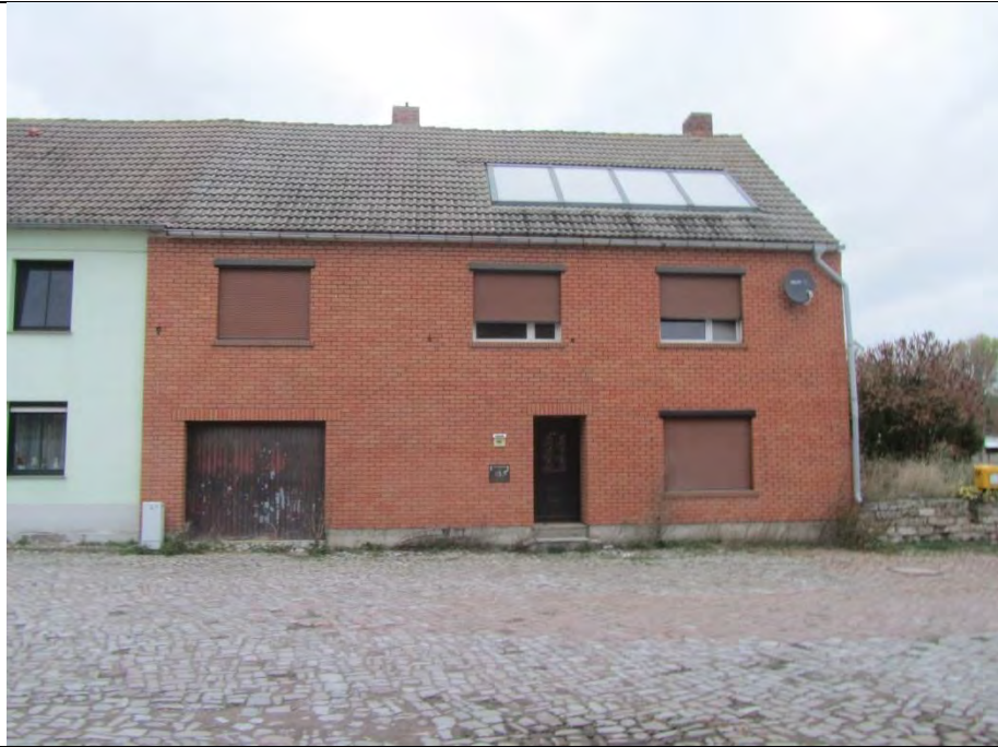
Blick von der Straße aus Südrichtung. Auf dem Dach befindet sich Warmwasserunterstützung.
