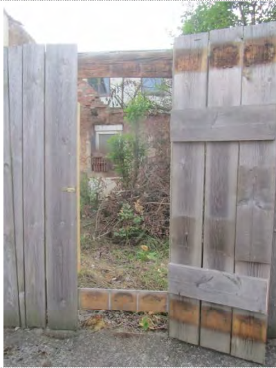
Zugang durch Schlupftür auf das Grundstück (FS 8004) von der Straße Feldberg aus
