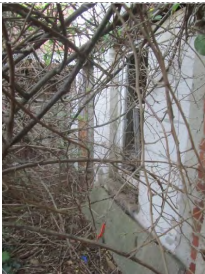
Westgiebel von der Bauruine mit Zugang zum Keller
