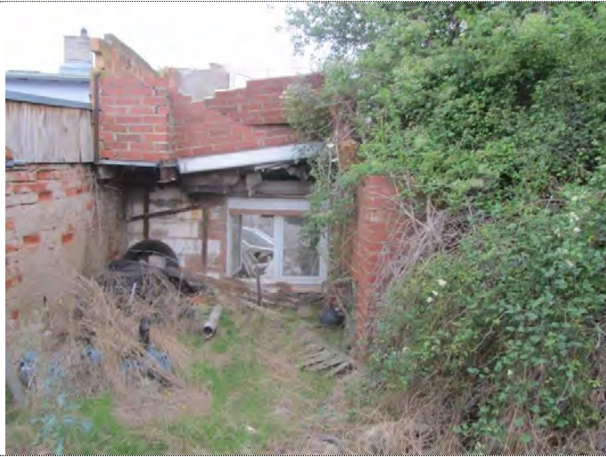
Blick zurück nach N rechts unter dem Gebüsch die Zugänge zum Keller und zum Heizraum
