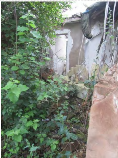
links daneben ehem. Veranda
