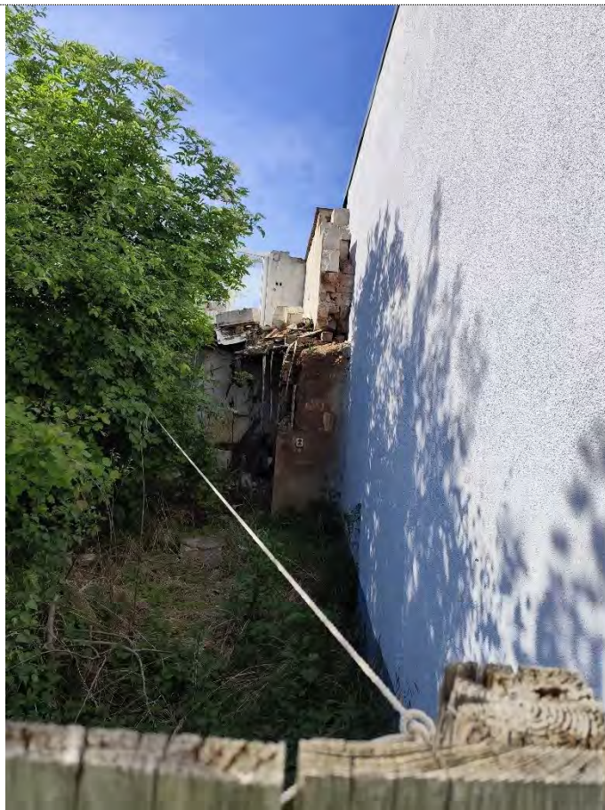
Blick auf einen Teil der Bauruine mit Blickrichtung Süden
