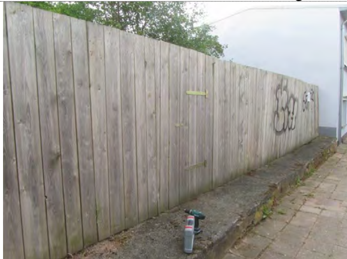
Holzzaun mit Schlupftür an der nördlichen Grundstücksgrenze des Flurstücks 8004; Blick nach W
