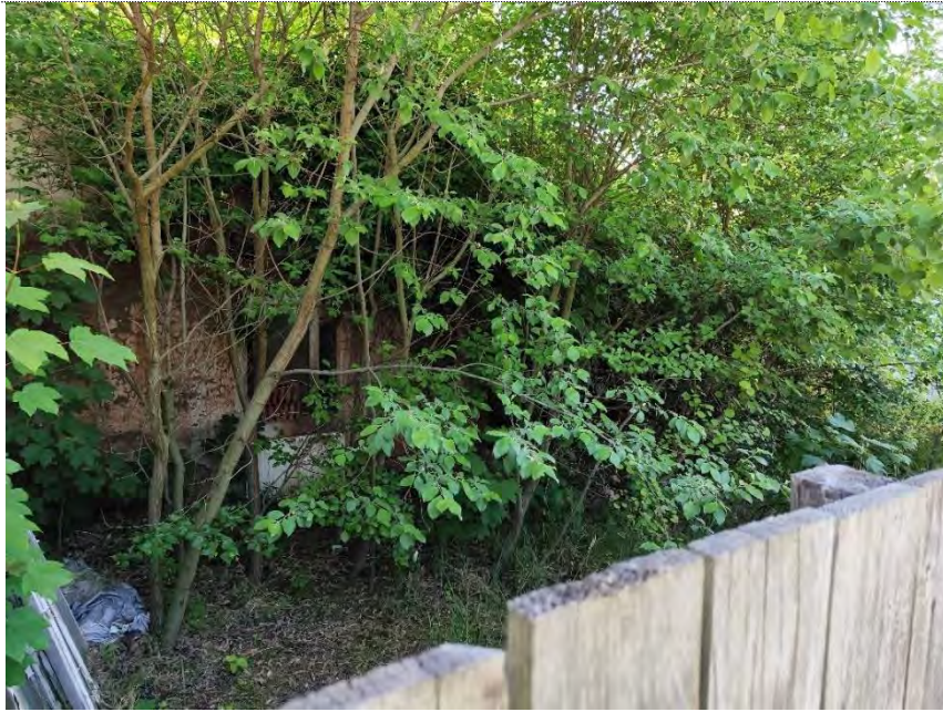
Blick über den Zaun auf das Grundstück in Richtung Südwest: Wildwuchs und altes Lehmgebäude
