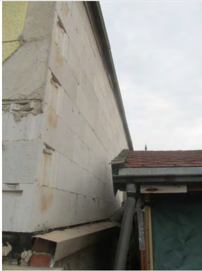
Fassade von der Bauruine Grenzbebauung
