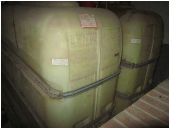
nach Osten - Öltanks – offenbar leer
