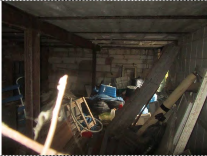
Blick in den Keller nach W
