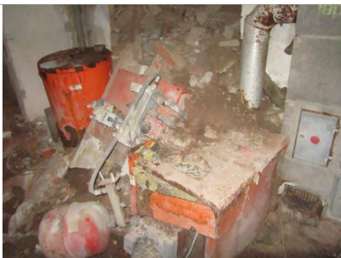
Blick nach W - Reste des ehem. Heizkessels
