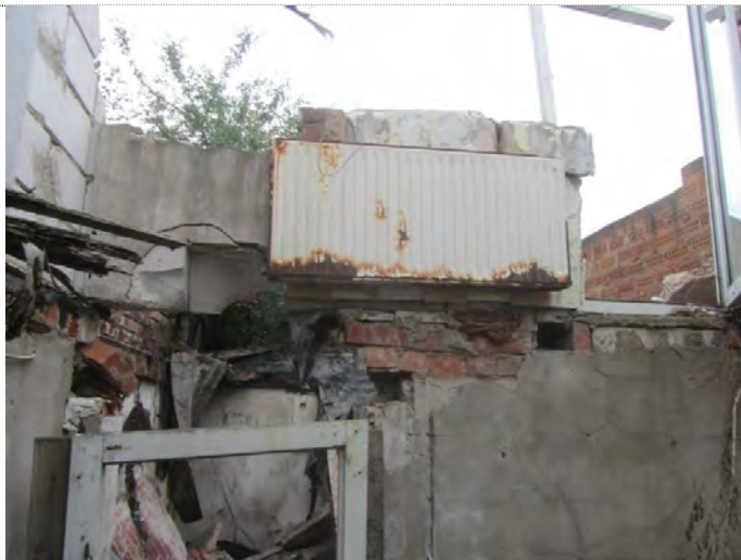
da gab es offenbar mal ein Obergeschoss
