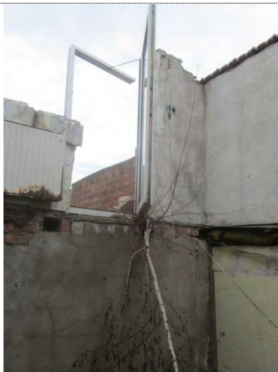
Reste einer Terrassentür
