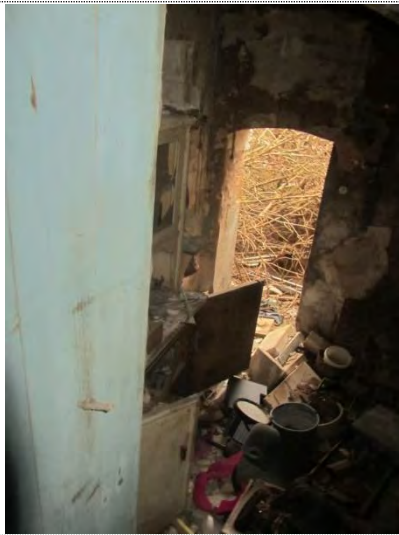
Blick nach NO in den Raum
