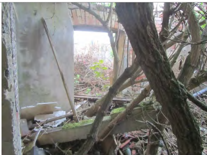
Blick vom Heizraum Richtung Straße nach N
