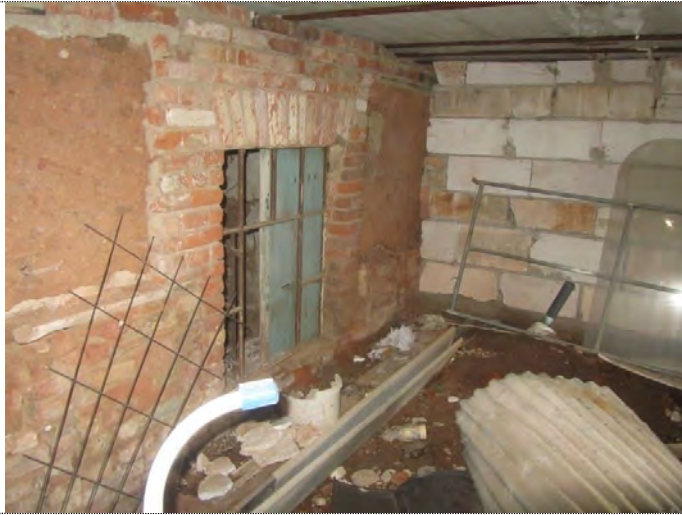
Blick in den Keller nach NW mit Fenster zum Raum westlich vom Heizraum
