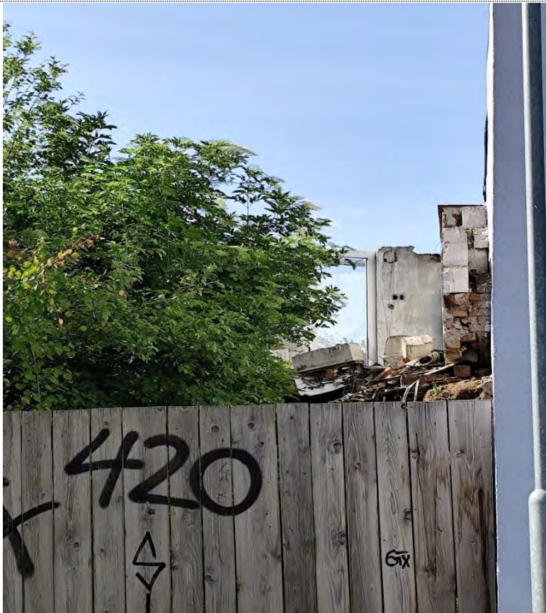
Blick über den Zaun auf einen Teil der Bauruine mit Blickrichtung Süden
