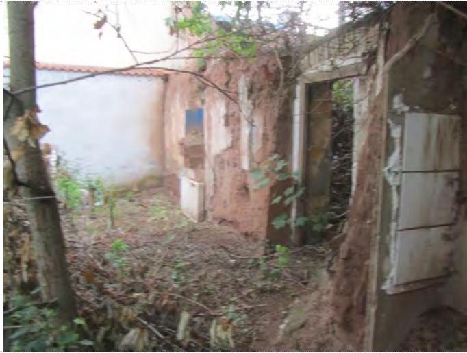
Nordfront Blick nach W
