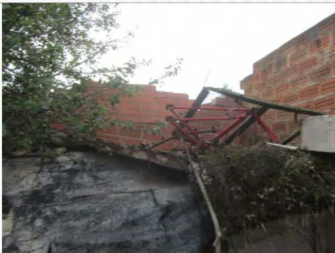
Blick nach W
