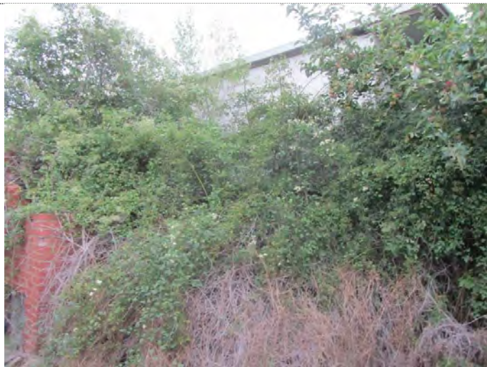
Blick zurück nach NO rechts unter dem Gebüsch die Zugänge zum Keller und zum Heizraum
